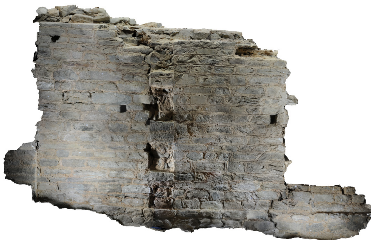
Figura 9 – Ortofoto cilindrica di precisione dell'abside circolare ad est. della rappresentazione 1:10.
