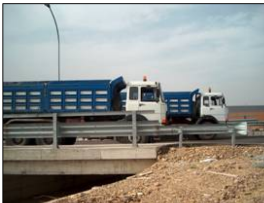
Figura 5: prova di carico su ponte
