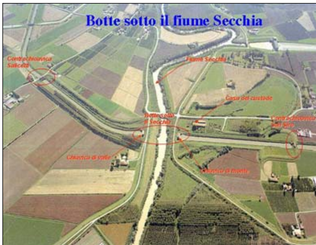
Figura 3 – vista aerea complesso idraulico Botte sotto il Secchia
