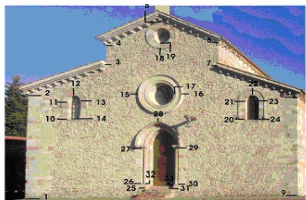
Figure 2,3 – Punti di appoggio sul fronte principale e sulla zona absidale della chiesa
