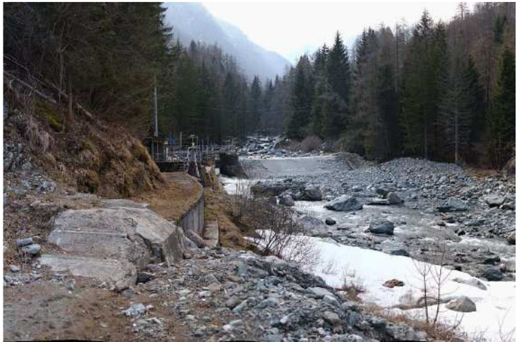
Figura 1- Opera di presa e canale di derivazione dell'impianto di Hône 2
