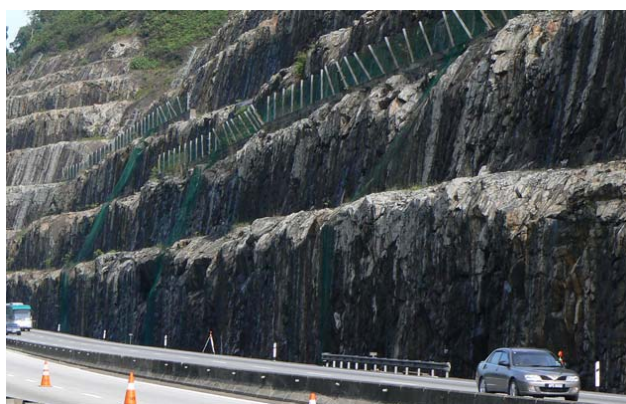
Figura 8 - Estesa presenza di elementi di protezione come reti metalliche
