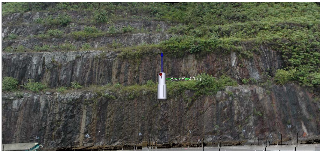
Figura 12 e 13 - Nuvola punti 3D colorata di una scansione di dettaglio (sopra) e generale (sotto)
