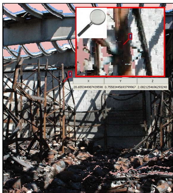
Figura 4 – Immagine 2D con informazioni 3D degli interni del capannone
