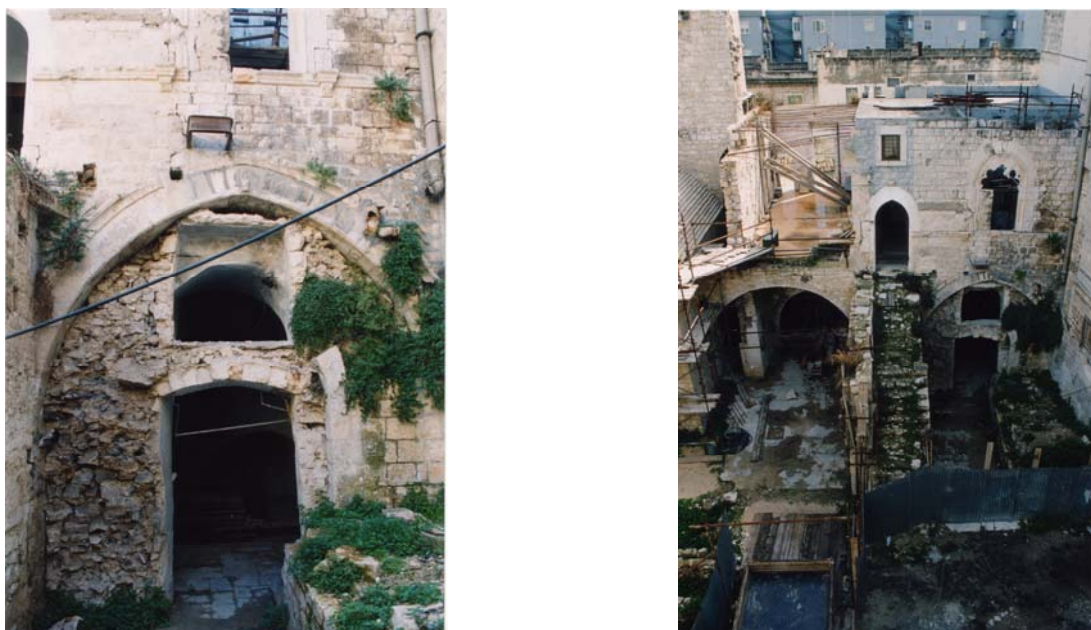
Figure 3 a/b La corte interna del castello all'inizio della prima fase dei lavori
