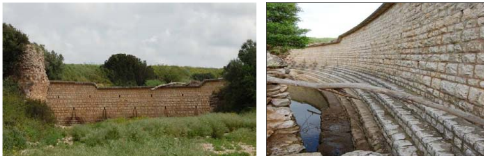
Figura 1 - Particolare della briglia a valle
