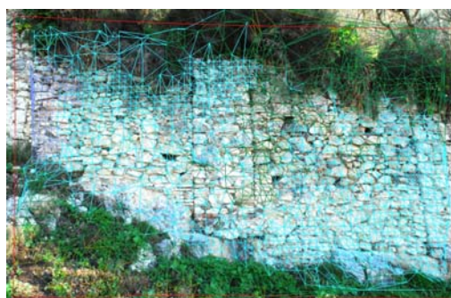
Figura 2 – Modello TIN ottenuto tramite fotogrammetria tradizionale
