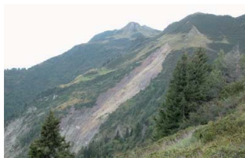
Figura 2: Vista dell'area di frana da Nord.
