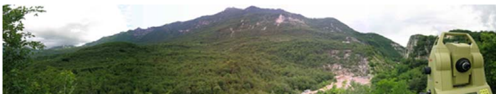
Figura 2 - Vista della zona di frana da una delle stazioni della rete topografica
