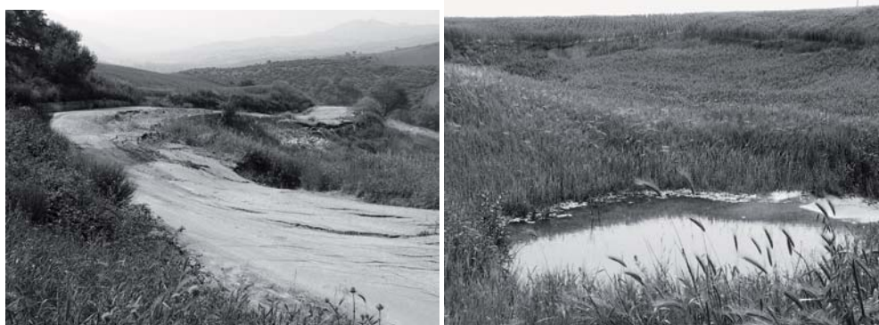
Fig. 1. (sinistra)– frana su un tratto della SP99bis. (destra) – ristagno d'acqua sotto la nicchia di distacco di una frana.
