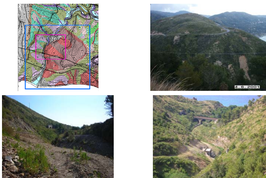
Figura 1 – Area interessata dalla frana (quadrato grande in azzurro tutta l'area, quadrato piccolo in viola l'area di maggior deformazione) e alcune vedute dell'area in frana
